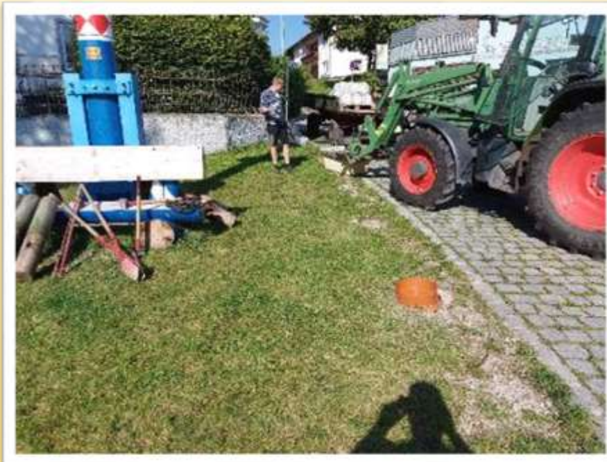
Einbringen des Betons
