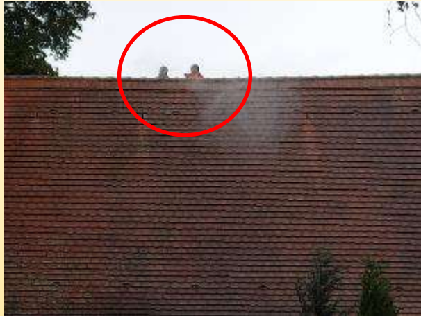
Dachseite Süden - vorher
