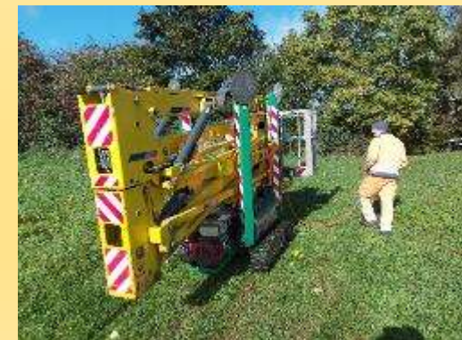
Einsatz der Hebebühne
