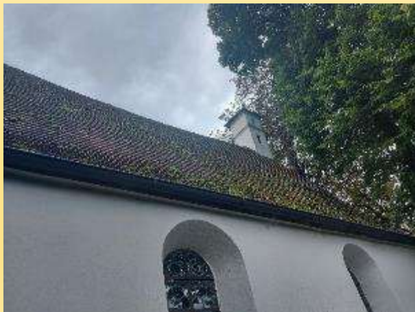
Dachseite Nord - vorher
