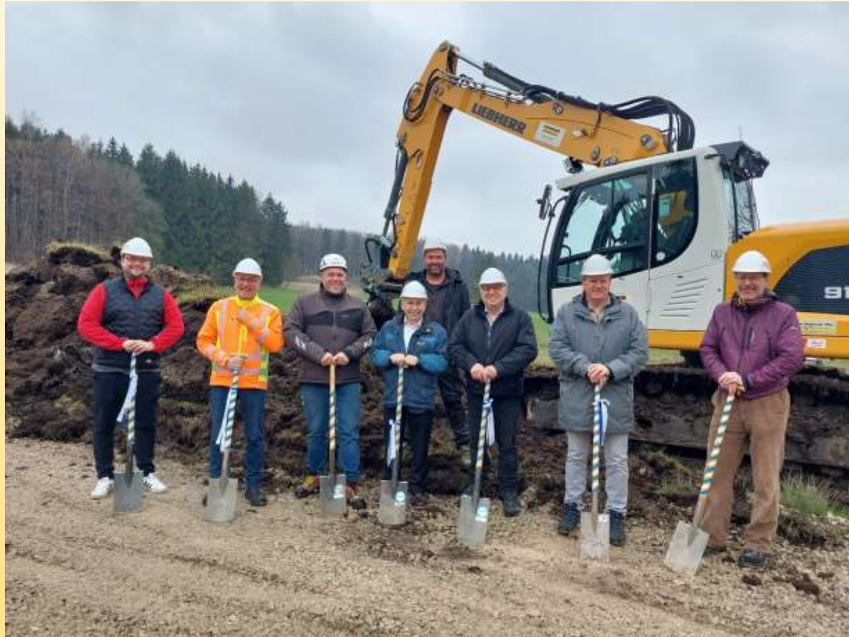
Spatenstich Bau Hochbehälter im April 2023
