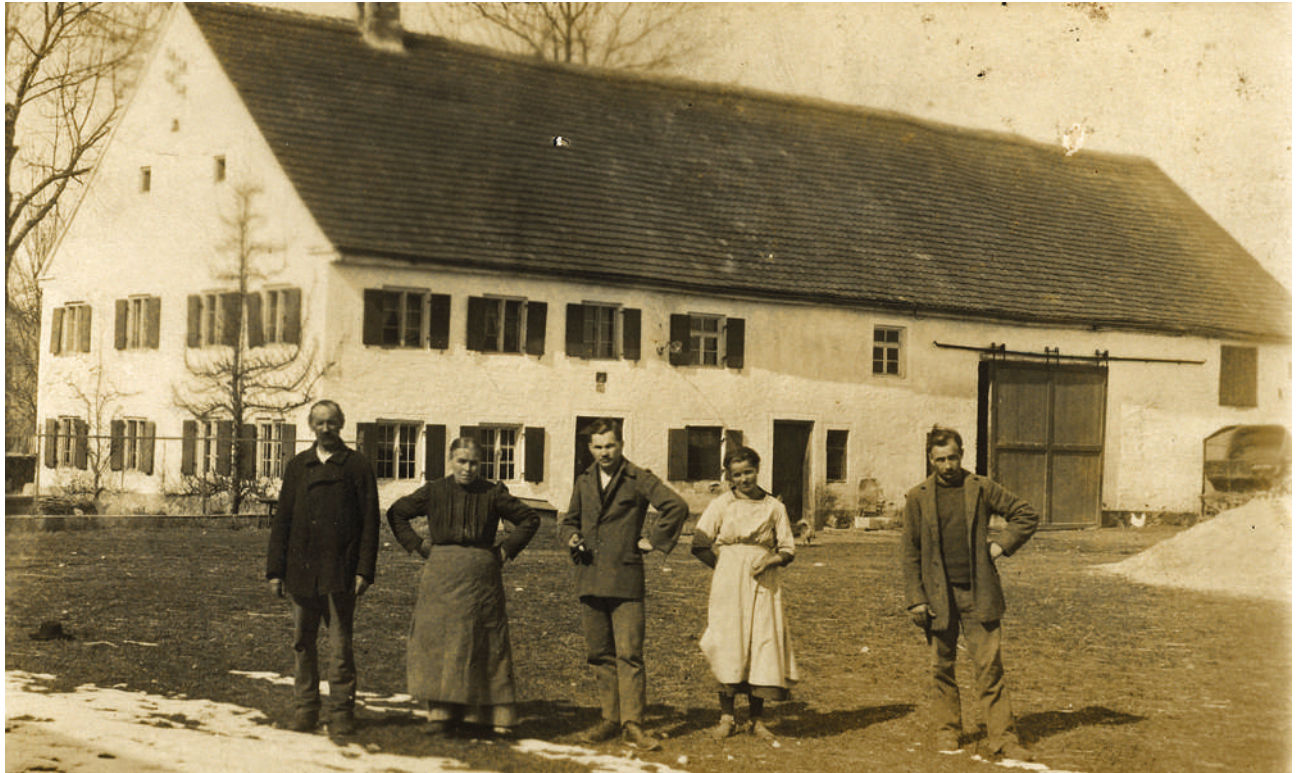
Kusterer Straße 9 – Alte Hausnummer Hurlach 59 – Das älteste Haus in der Kustererstraße, erbaut etwa Mitte des neunzehnten Jahrhunderts
