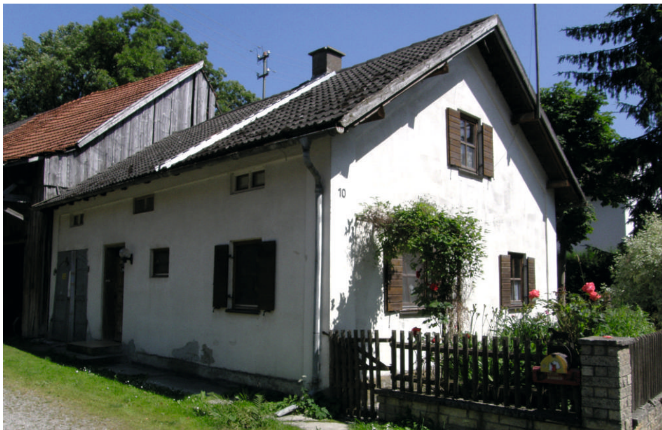
Meitingenstr. 10 – Alte Hausnummer Hurlach 119; Austragshaus von alter Hurlach Nr. 18
